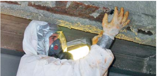
Asbestsanierung
